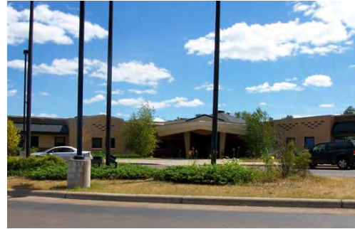
Fond du Lac Tribal Center
