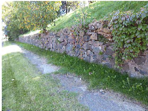
409 Arch Street (Avenue D side)
